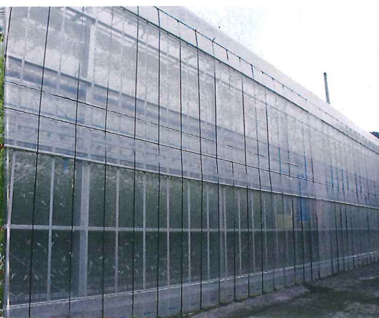
↑平成27年4月に完成した完全環境制御型の多連棟ハウス。
